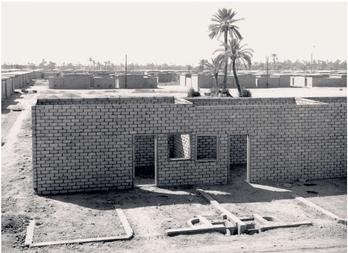
Fig. 12 : Deux logements avant la pose des éléments de toiture (FAM).
