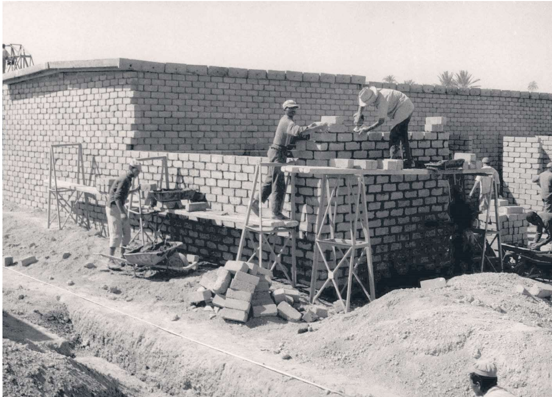
Fig. 9 : Montage des murs en blocs de terre comprimée — BTC (FAM).
