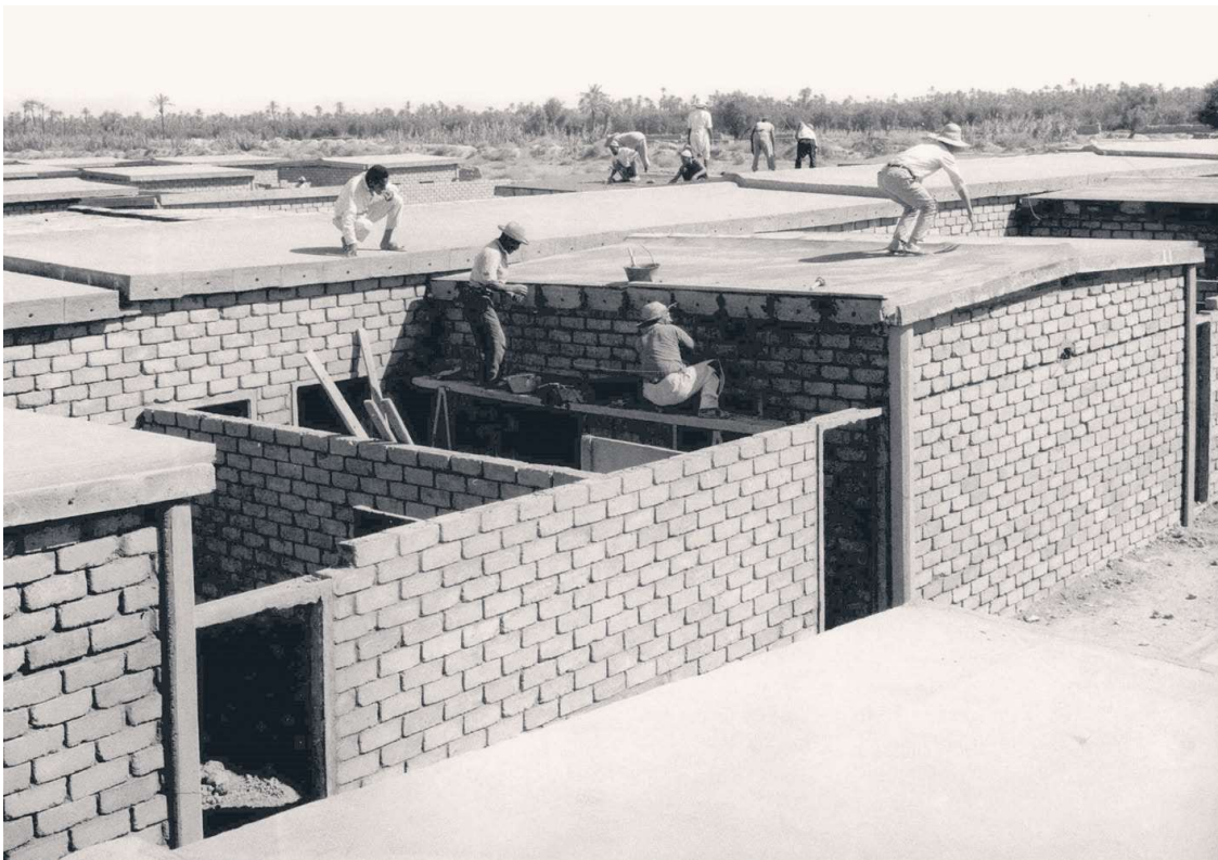
Fig. 10 : Finition des toitures (FAM).
