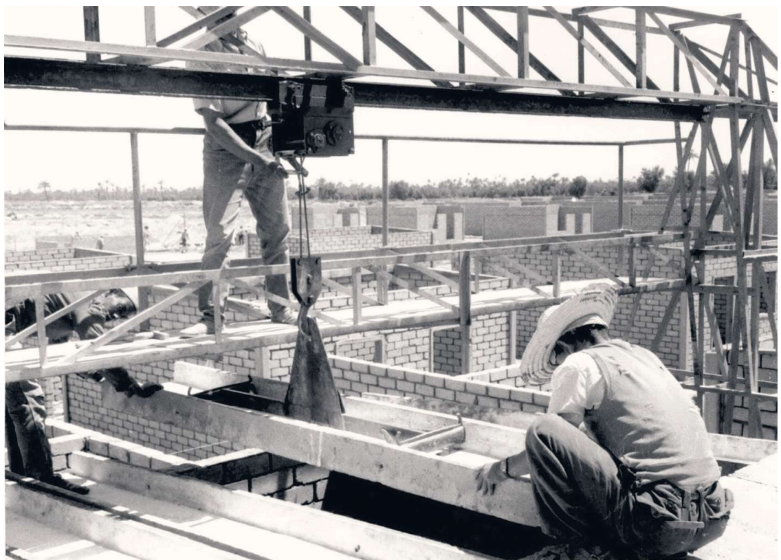
Fig. 8 : Pose des éléments de toiture (FAM).
