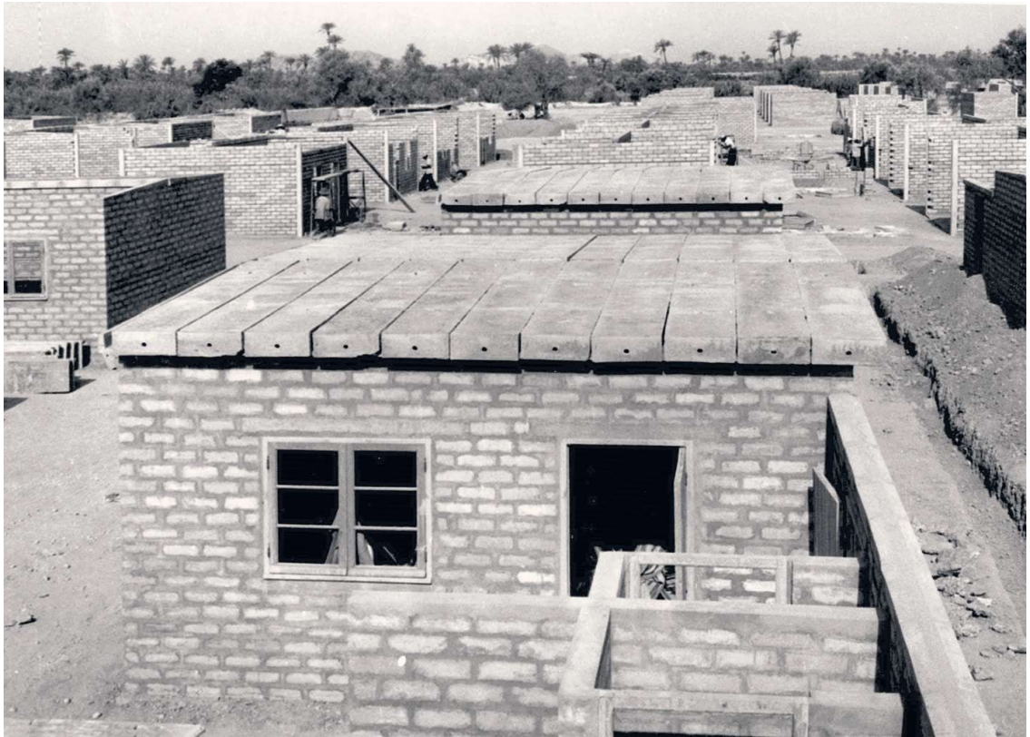
Fig. 11 : Pose des éléments de toiture (FAM).
