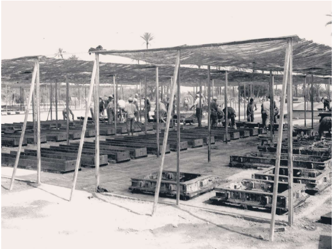
Fig. 7 : Préfabrication d'éléments en ciment (FAM).
